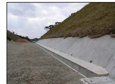
張りコンクリート部の例
