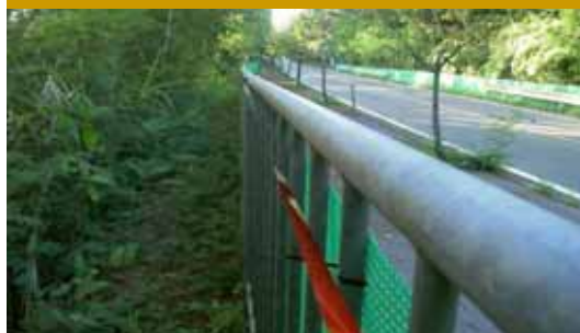
転落防止柵利用区間
