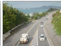
金武バイパス本線跨道橋から 浜田漁港方面を望む
