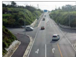
金武バイパス本線跨道橋から 金武中学校方面を望む
