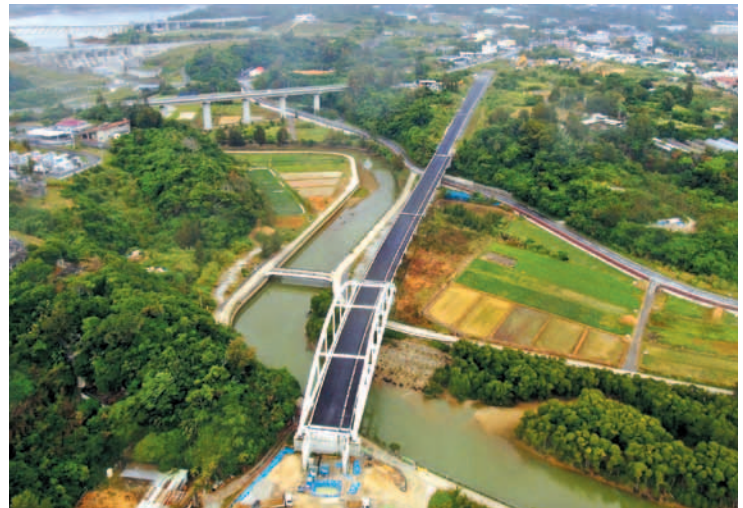
金武バイパス【1号橋：上部工工事】
