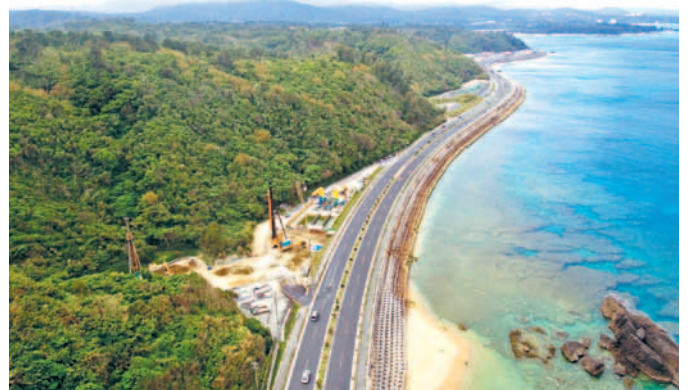
▲名護東道路（施工中の数久田IC（終点）付近）
