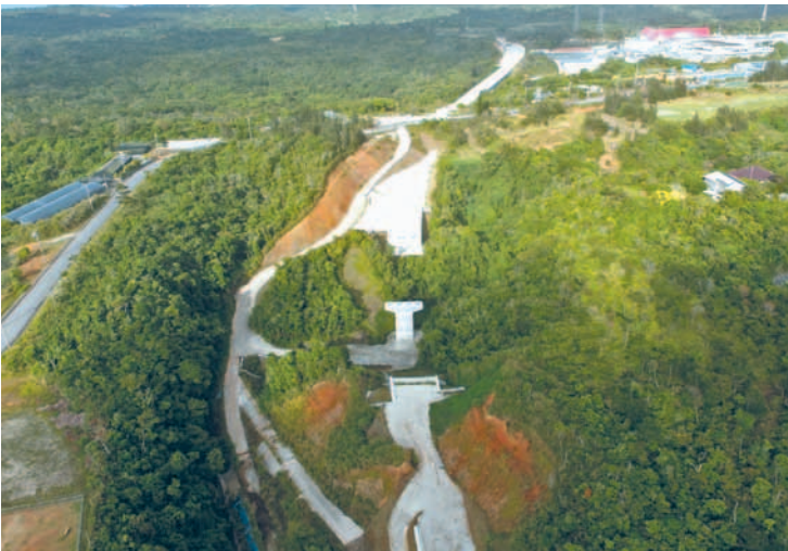
読谷道路【1・2号橋：上部工工事】
