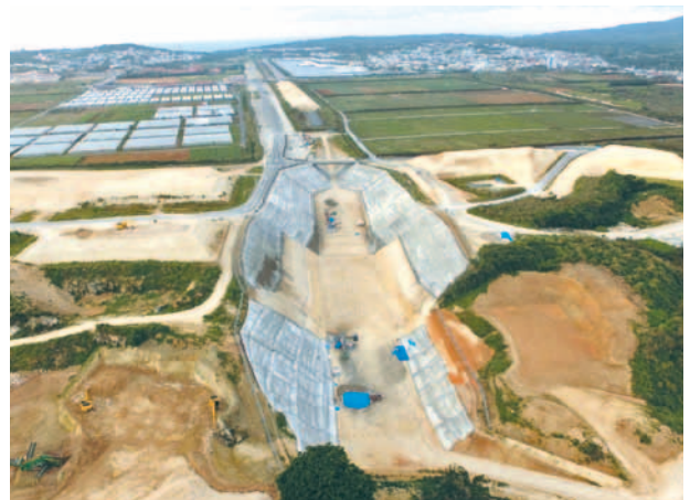
▲読谷道路（施工中の5工区開削トンネル）
