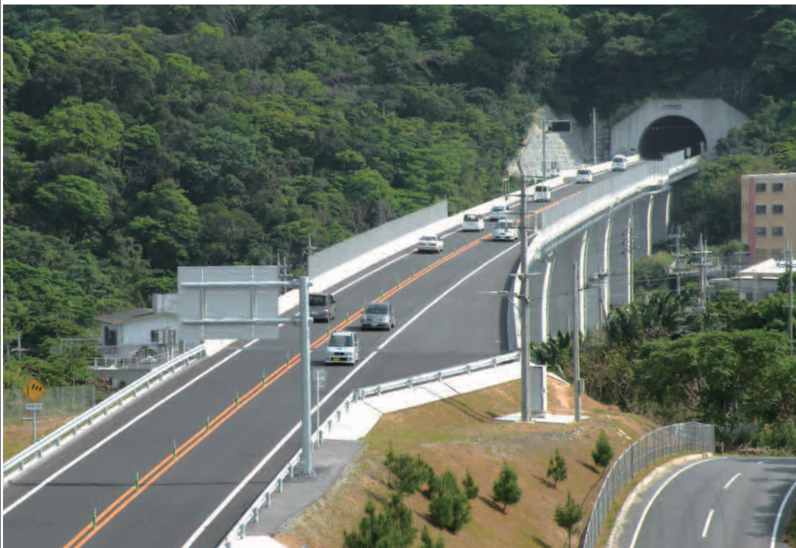
国道58号名護東道路
