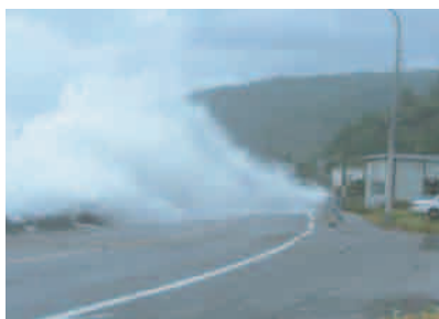
通行規制区間における越波状況
