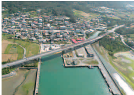
② 羽地大橋（補修）
