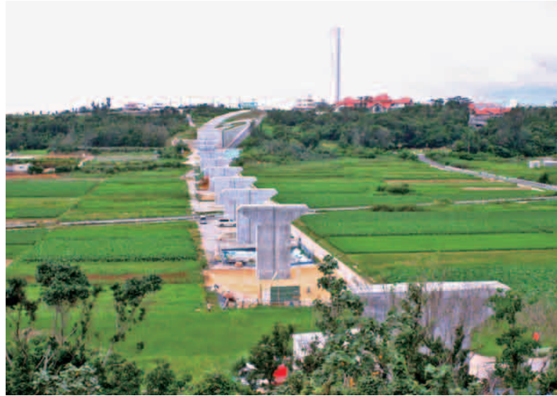
工事区間の状況【中間部(金武宇謝原)付近】
