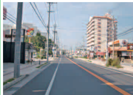
② 前兼久地区電線共同溝
