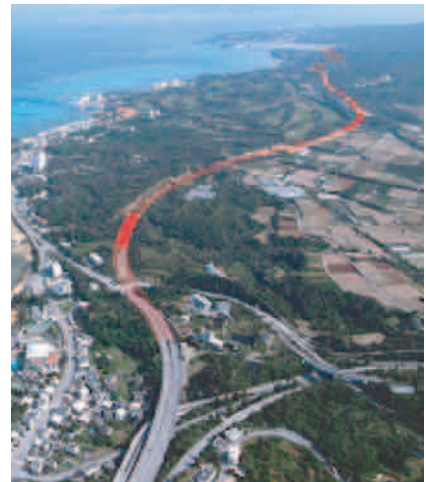
▲事業ルート(恩納村仲泊付近から起点を望む)
