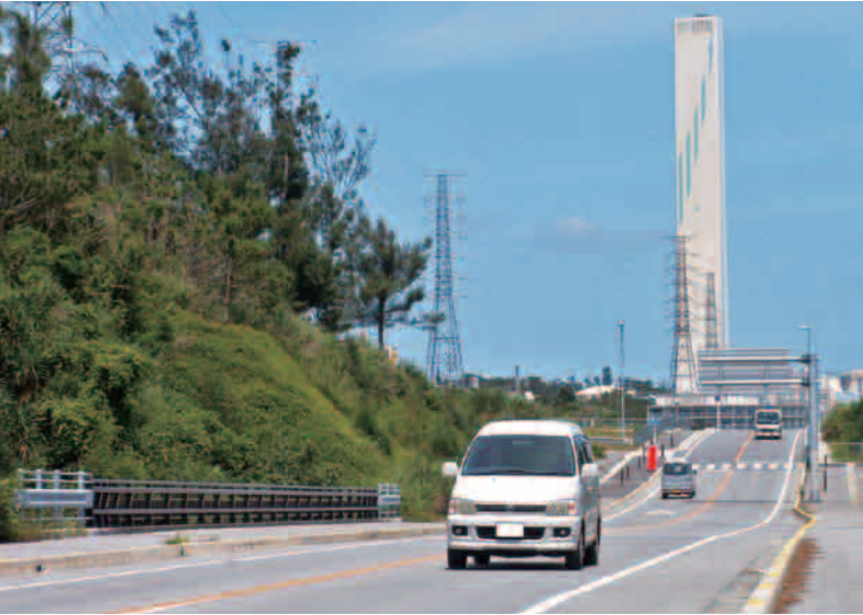
供用区間の状況【終点(金武渡慶頭原)付近】
