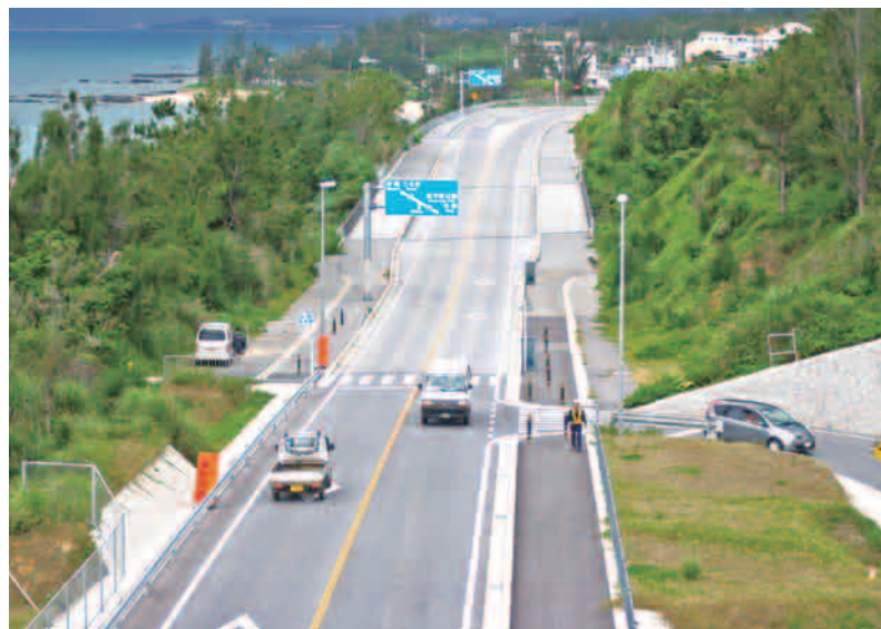
供用区間の状況【終点(金武IC方面)を望む】
