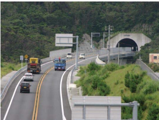
名護東道路【起点(伊差川)付近】
