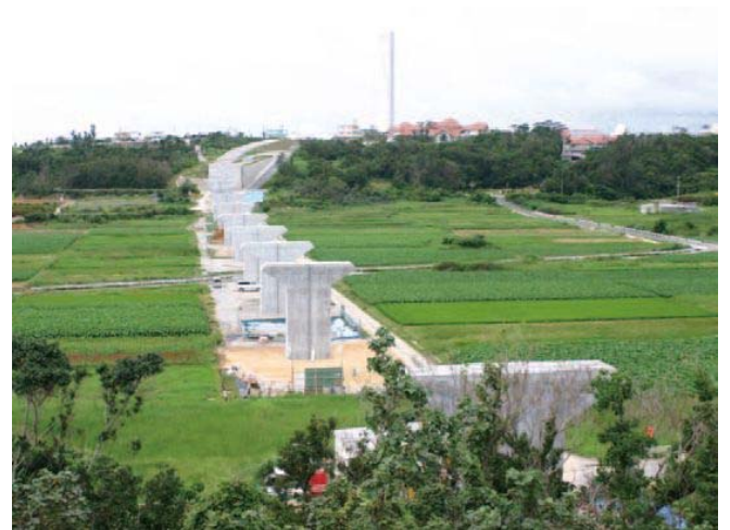
金武バイパス【2号橋(島兼原)付近】
