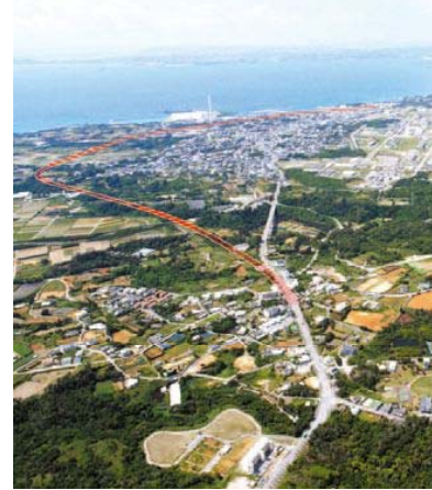
▲事業ルート(金武町中川付近から終点を望む)
