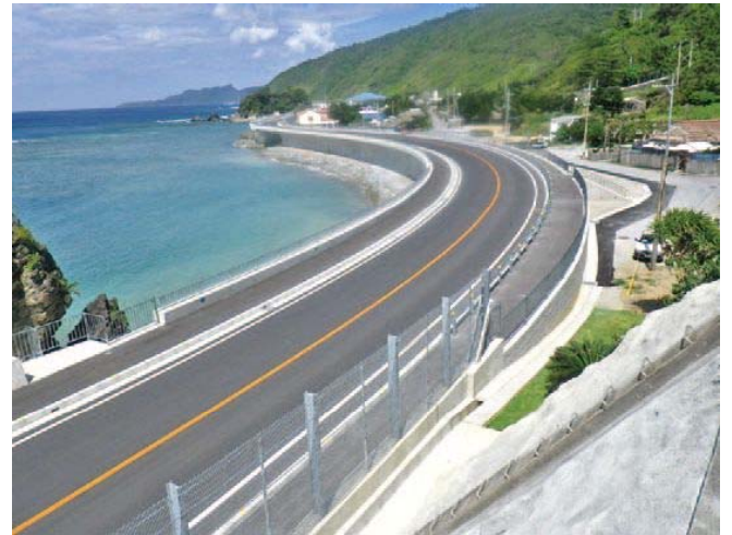
謝敷拡幅【フレア護岸(国頭村謝敷)付近】
