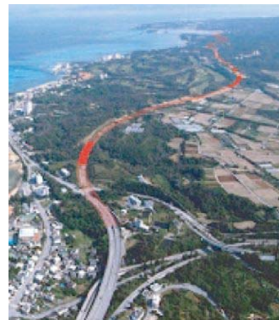
▲事業ルート(恩納村仲泊付近から起点を望む)
