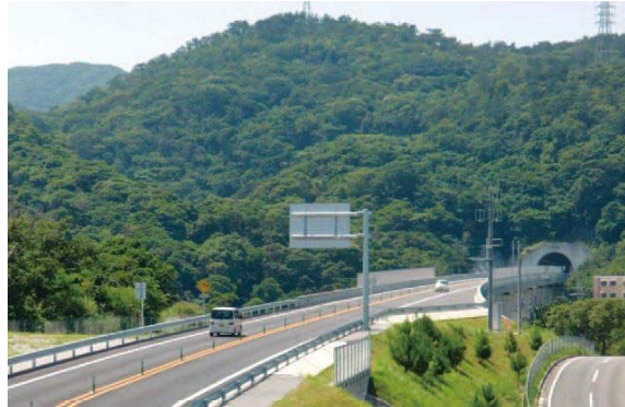
▲名護東道路(伊差川IC付近から名護大北トンネルを望む)
