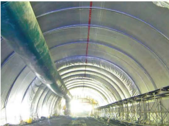
名護東道路【3号トンネル：覆工コンクリート養生】
