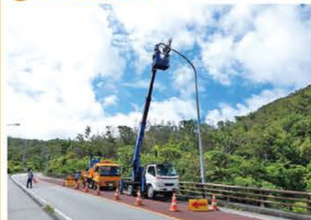
③ 道路照明点検
