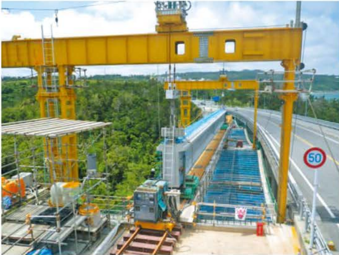
恩納南バイパス【4号橋：主桁架設工事】
