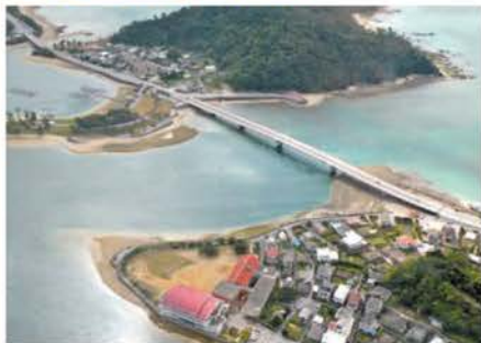
① 塩屋大橋
