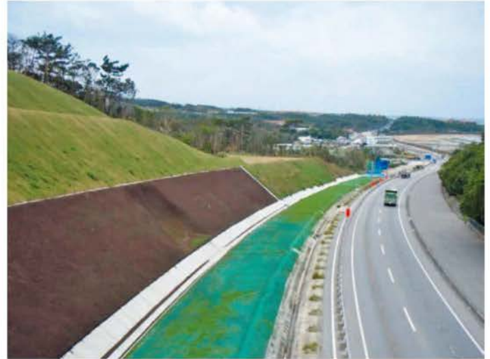
恩納バイパス【法面工事】
