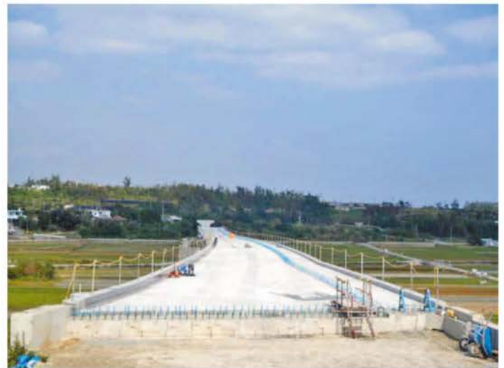
金武バイパス【2号橋：橋梁床板工事】
