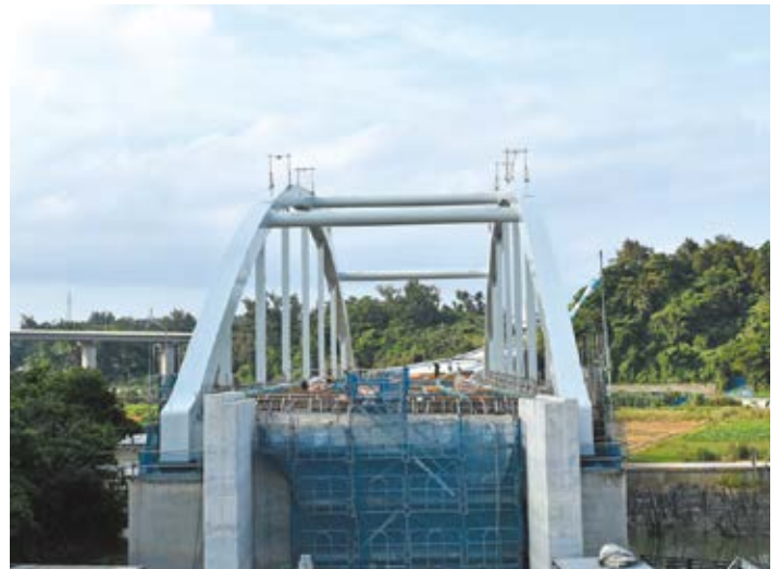
金武バイパス【1号橋：上部工工事】
