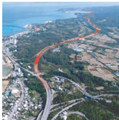
▲事業ルート(恩納村仲泊付近から起点を望む)
