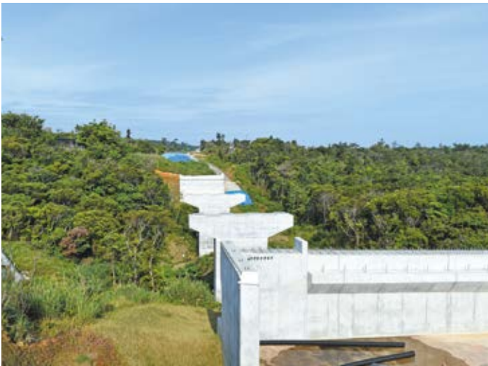
読谷道路【1号橋：下部工工事】
