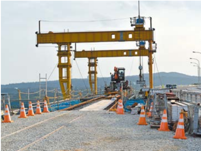
恩納南バイパス【3号橋：上部工工事】
