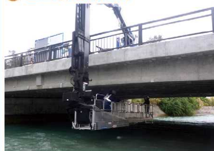
① 橋梁点検状況
