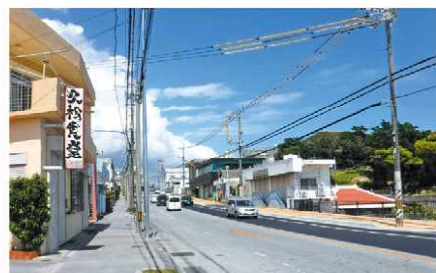
① 金武並里地区電線共同溝
