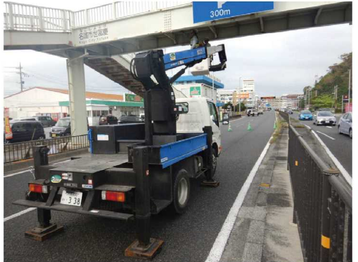
歩道橋点検【世富慶歩道橋】
