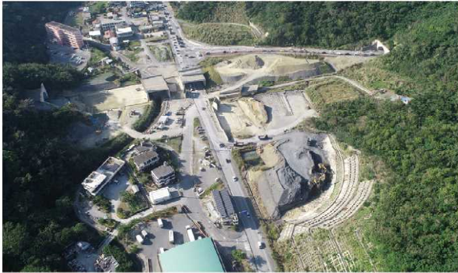
▲名護東道路施工中の世富慶IC(右が2号TN終点、左が3号TN起点)
