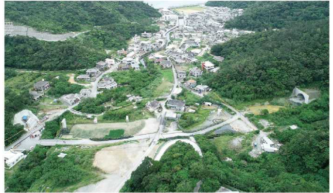
▲名護東道路施工中の数久田高架橋(右が3号TN終点、左が4号TN起点)
