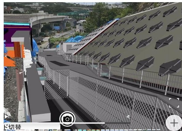
法面工・階段工の現場の状況に完成イメージ
