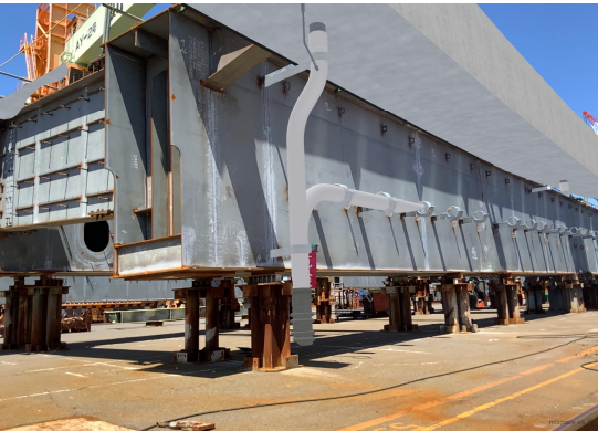
【ARを用いた出来形管理】
