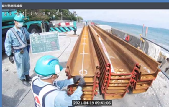
材料確認 現場
