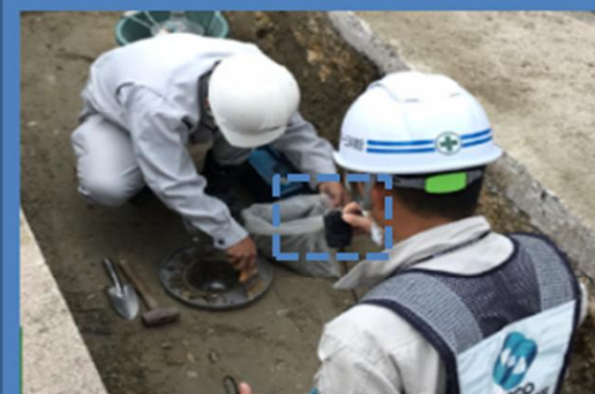
現場密度試験 現場
