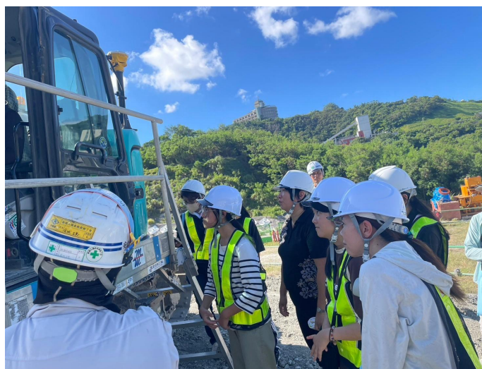
工事現場でICT建機の見学
