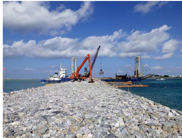
【II工区】捨石投入状況
