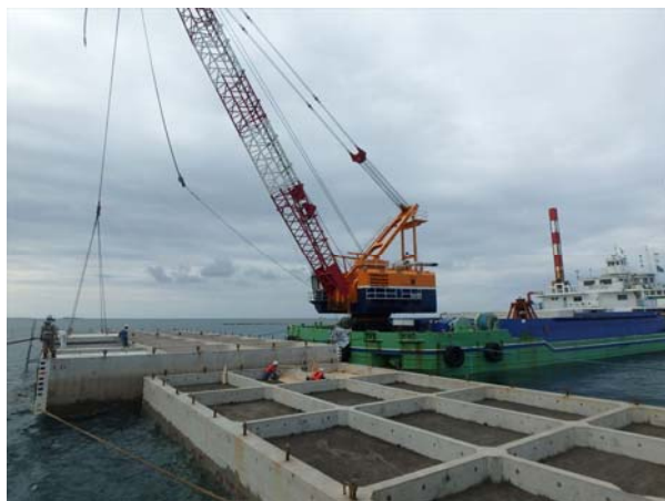
【南側】 蓋コンクリート設置状況
