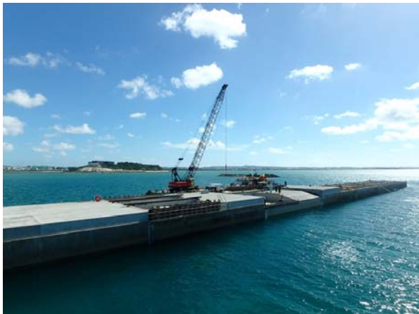
【I工区】上部施工状況
