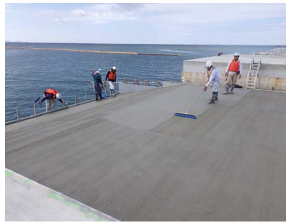
【南側】 上部コンクリート打設状況
