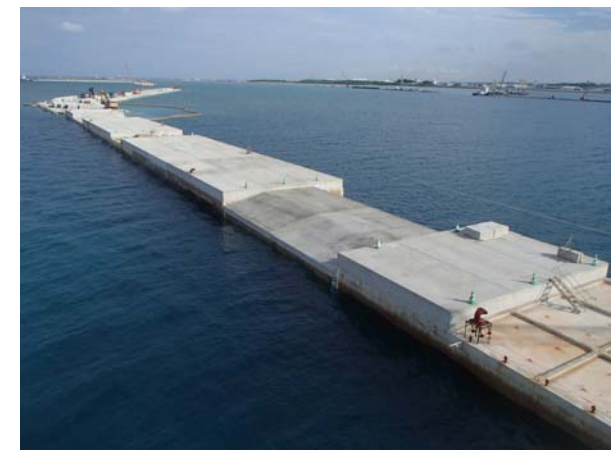
【南側】 ケーソン据付状況
