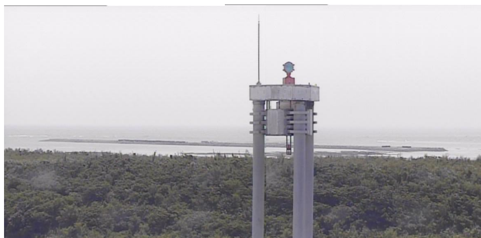
② 平成27年8月 護岸築造工事
