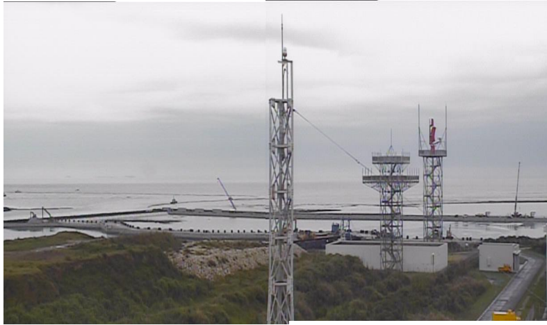
④ 平成27年5月 護岸築造工事
