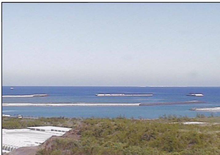
③ 平成27年7月 護岸築造工事
