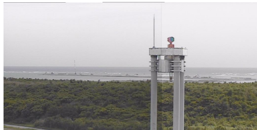
② 平成27年6月 護岸築造工事
