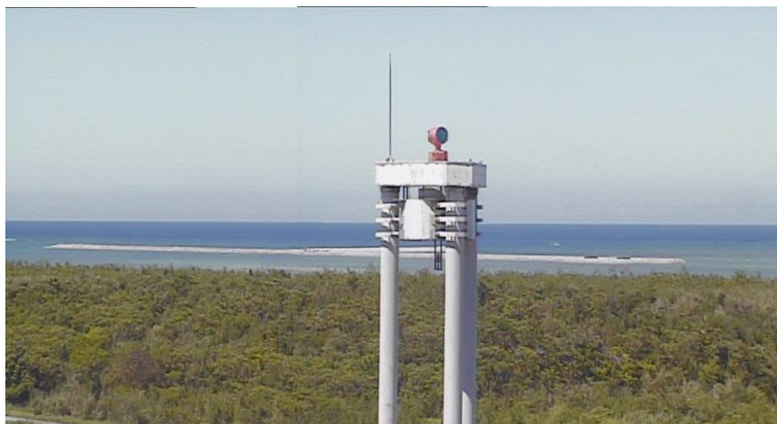
② 平成27年7月 護岸築造工事
