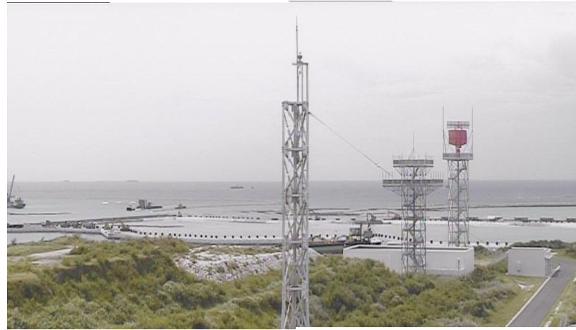
④ 平成27年6月 護岸築造工事
