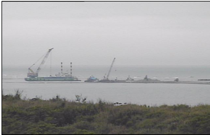
① 平成27年5月 護岸築造工事
