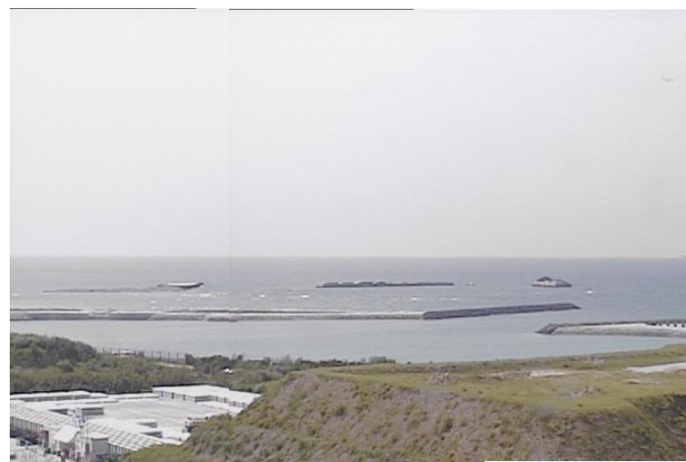
③ 平成27年8月 護岸築造工事
