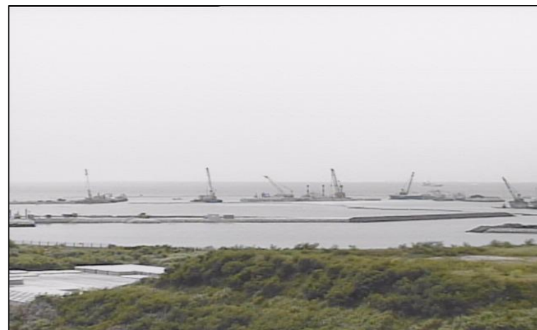
③ 平成27年6月 護岸築造工事
