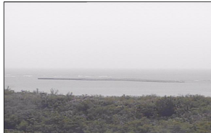
① 平成27年8月 護岸築造工事
