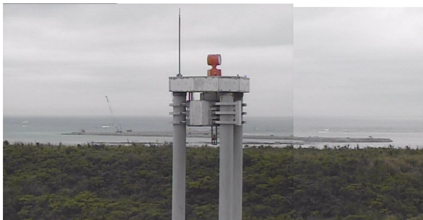
② 平成27年5月 護岸築造工事
