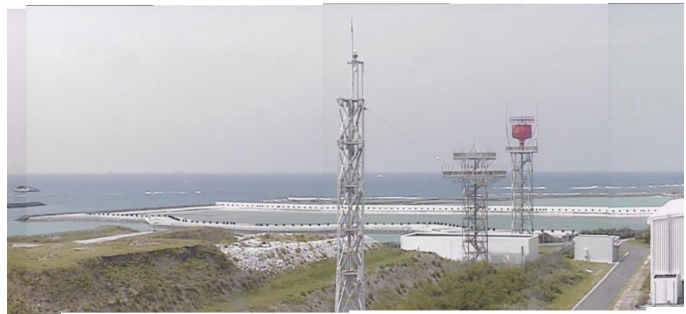
④ 平成27年8月 護岸築造工事・埋立工事
