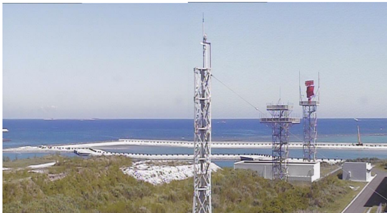
④ 平成27年7月 護岸築造工事
