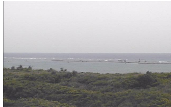
① 平成27年6月 護岸築造工事
