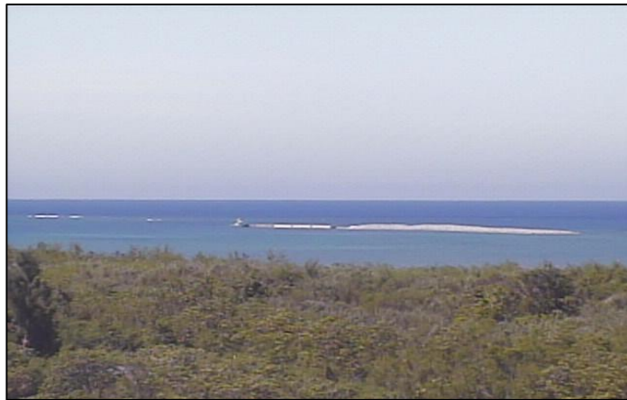
① 平成27年7月 護岸築造工事
