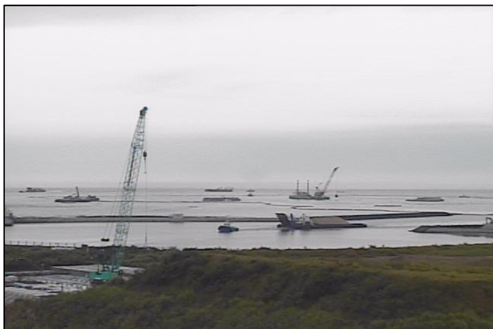
③ 平成27年5月 護岸築造工事
