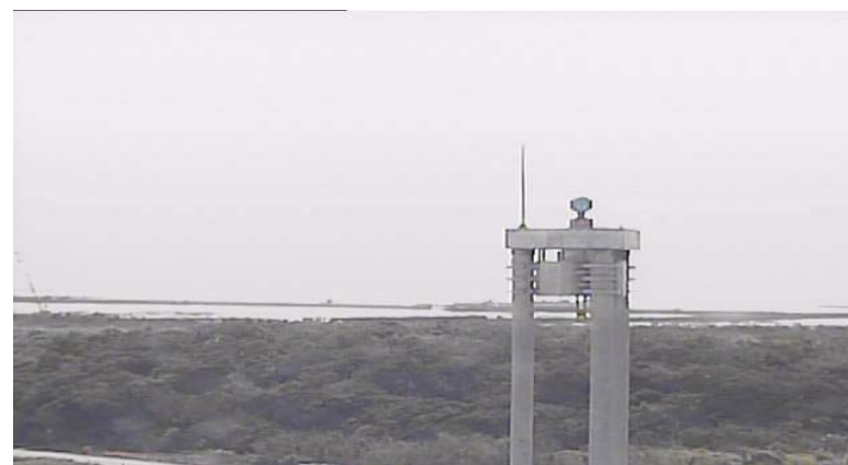
③ 平成28年2月 護岸築造工事
