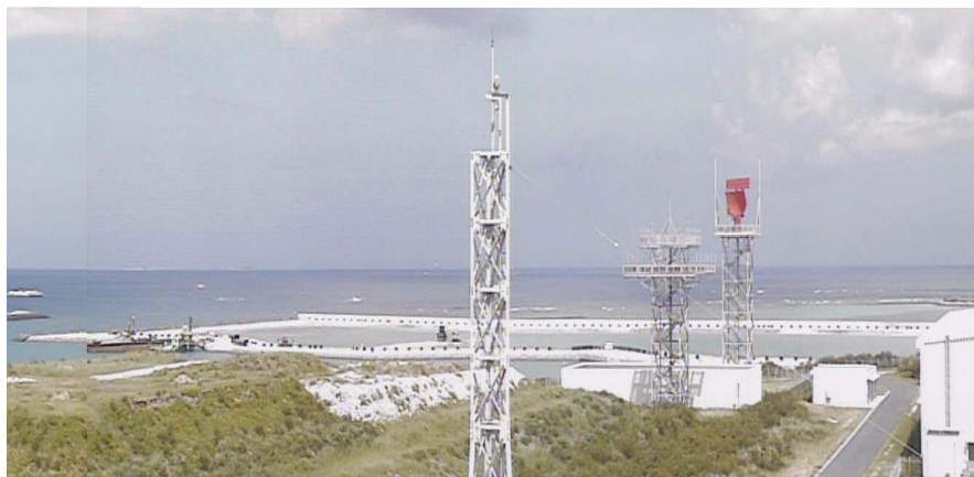
⑥ 平成27年9月 埋立工事
