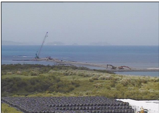
④ 平成27年9月 護岸築造工事
