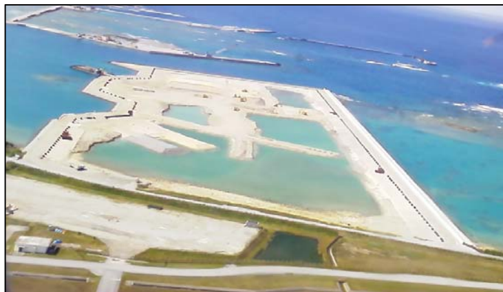
⑥ 平成28年1月 埋立工事(上空から)
