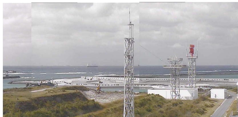
⑥ 平成28年2月 埋立工事
