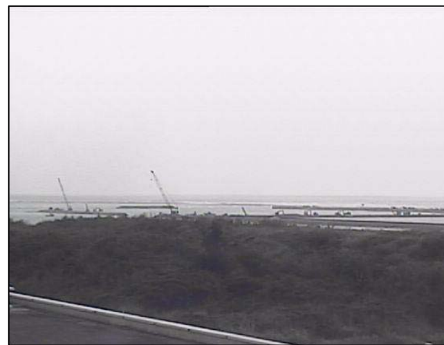
① 平成28年2月 護岸築造工事
