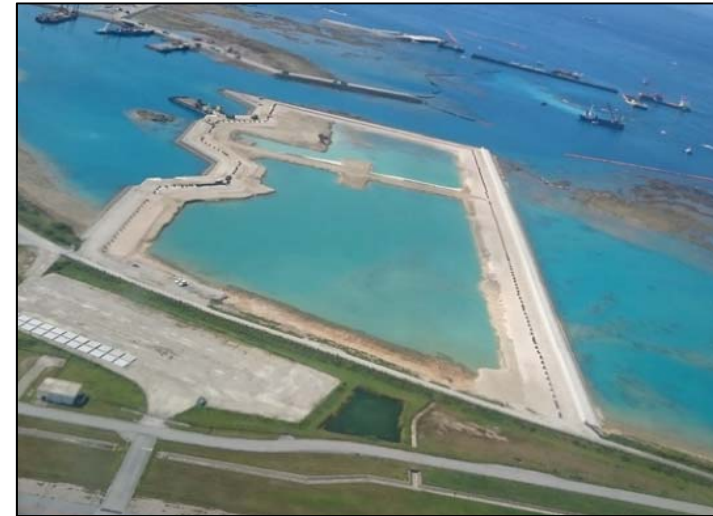
⑥ 平成27年10月 埋立工事(上空から)
