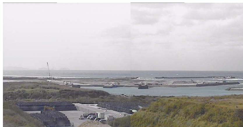
⑤ 平成28年2月 護岸築造工事
