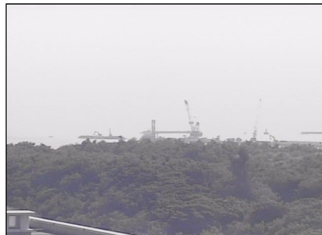
① 平成27年10月 護岸築造工事
