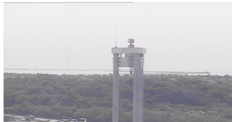
③ 平成27年10月 護岸築造工事
