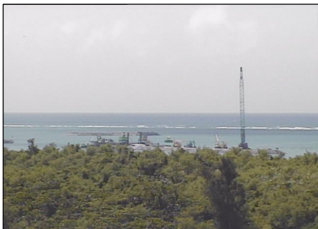
① 平成27年9月 護岸築造工事
