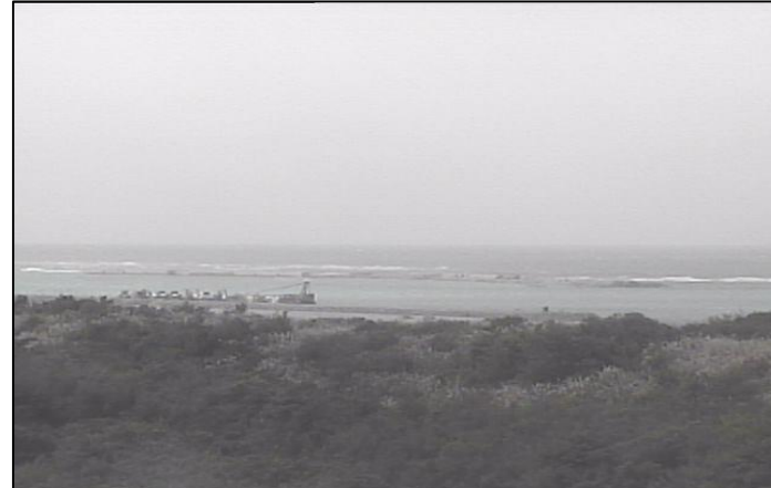
② 平成27年11月 護岸築造工事
