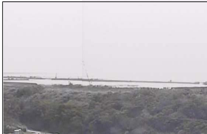
② 平成28年2月 護岸築造工事
