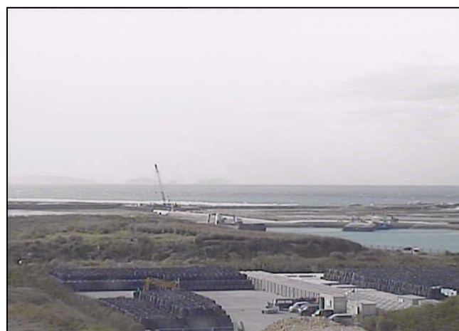
④ 平成28年2月 護岸築造工事
