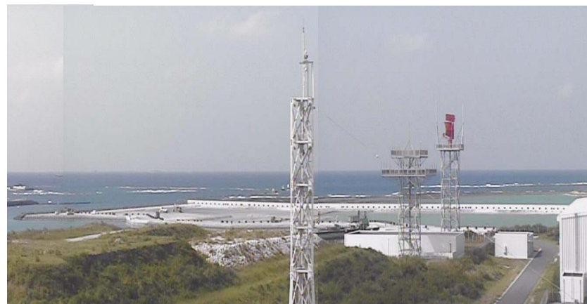
⑥ 平成27年10月 埋立工事
