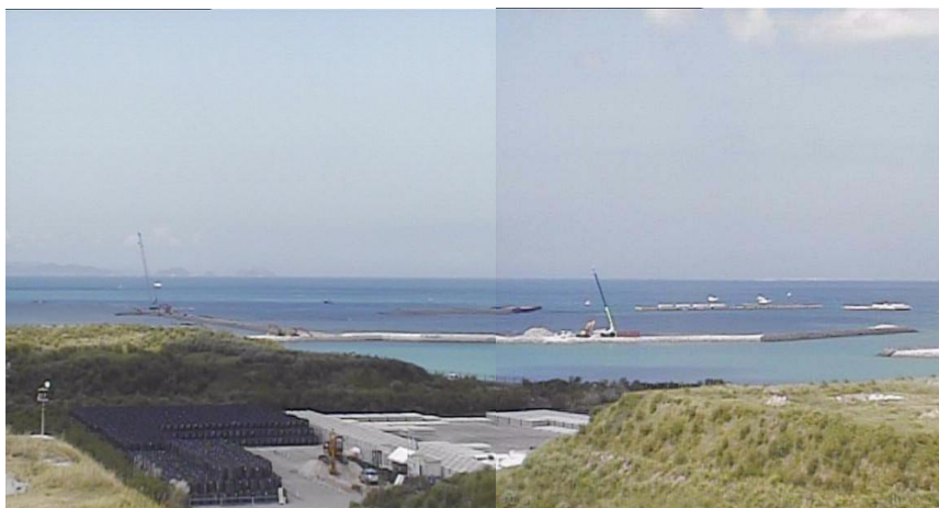
⑤ 平成27年9月 護岸築造工事
