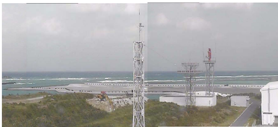
⑥ 平成27年11月 埋立工事
