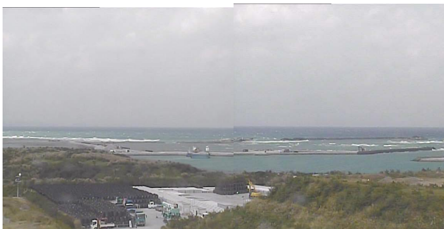
⑤ 平成27年11月 護岸築造工事
