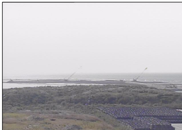
④ 平成27年10月 護岸築造工事
