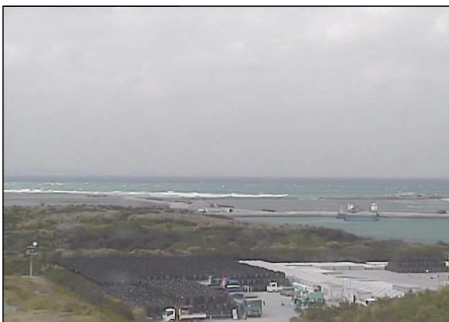
④ 平成27年11月 護岸築造工事
