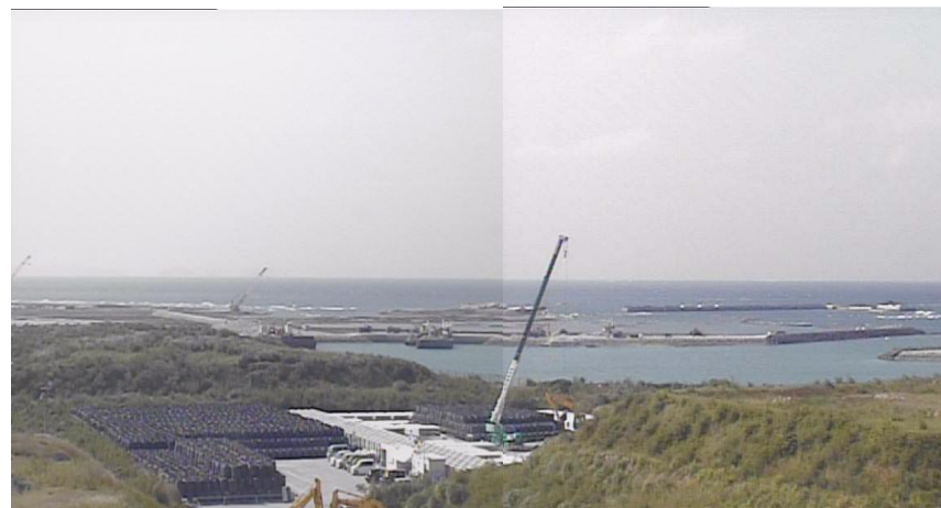
⑤ 平成27年10月 護岸築造工事
