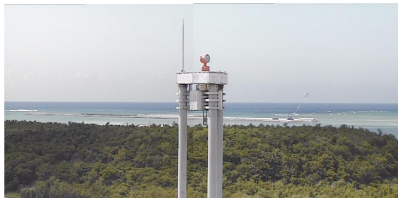
③ 平成27年9月 護岸築造工事
