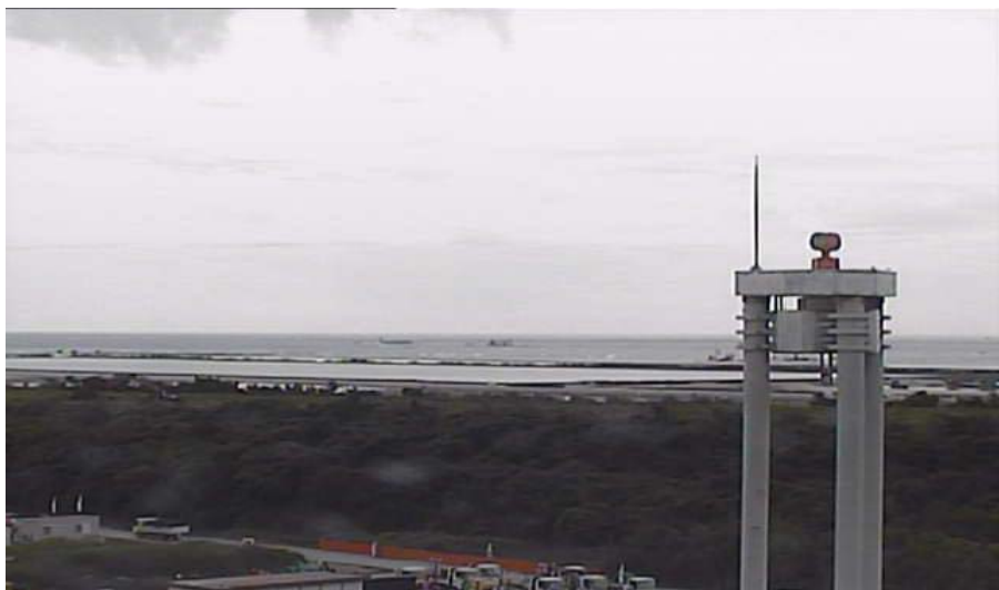
③ 平成28年5月 護岸築造工事
