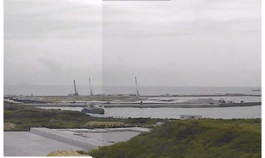
⑤ 平成28年4月 護岸築造工事
