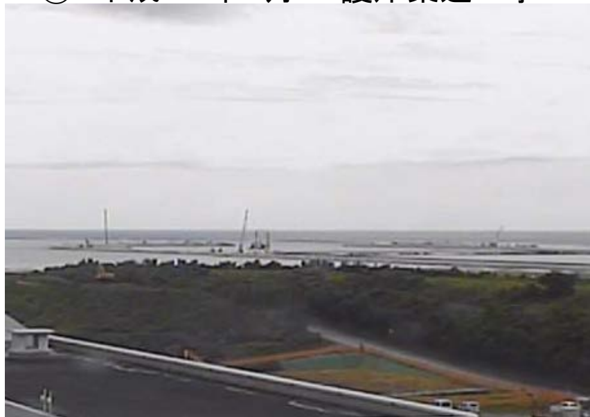
① 平成28年5月 護岸築造工事
