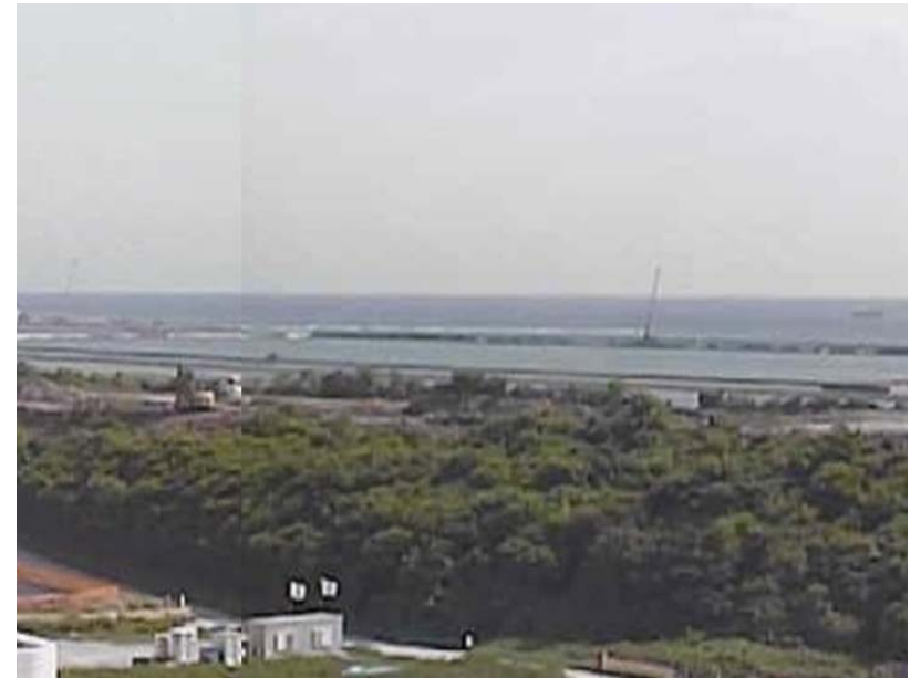
② 平成28年6月 護岸築造工事
