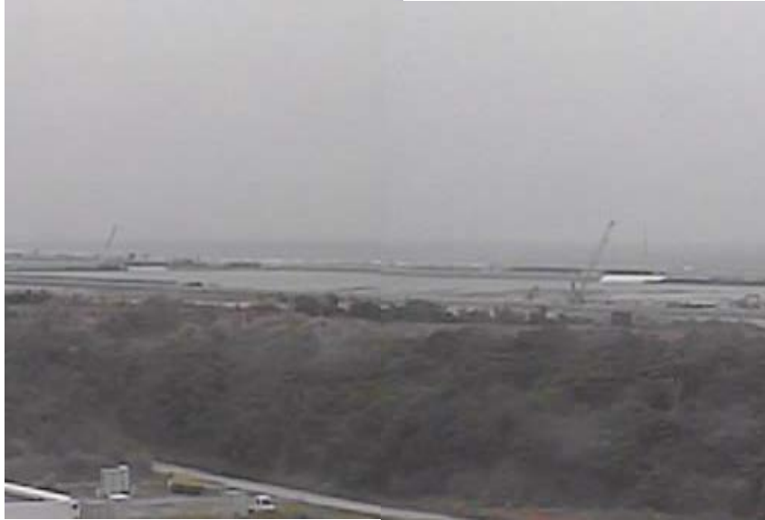
② 平成28年3月 護岸築造工事
