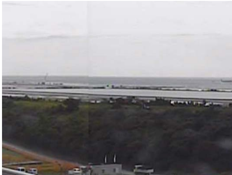
② 平成28年5月 護岸築造工事
