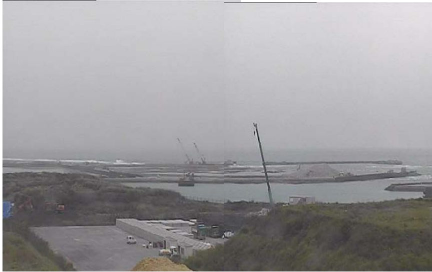
⑤ 平成28年3月 護岸築造工事
