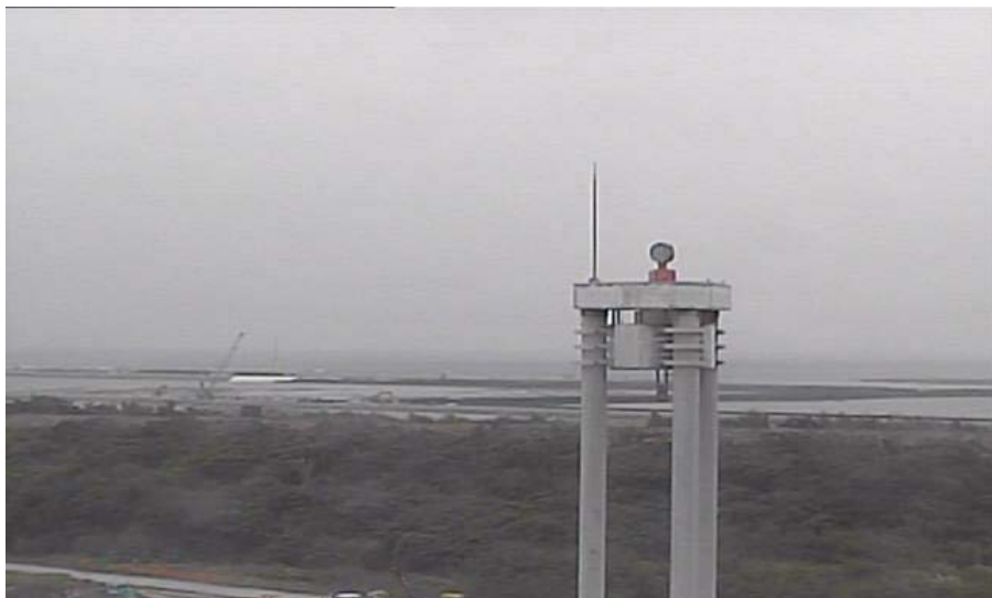
③ 平成28年3月 護岸築造工事
