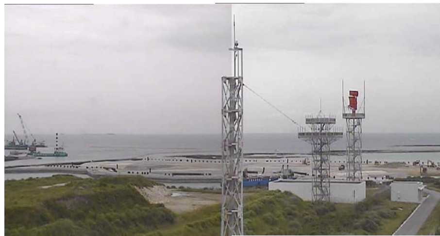
⑥ 平成28年4月 埋立工事
