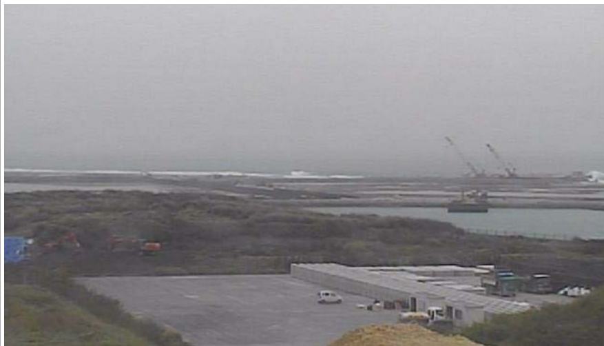
④ 平成28年3月 護岸築造工事
