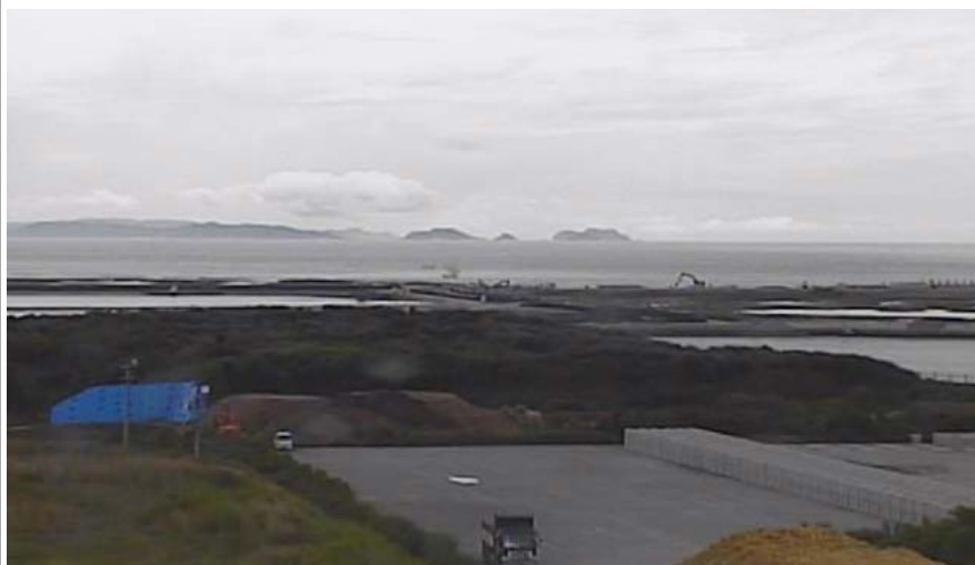
④ 平成28年5月 埋立工事
