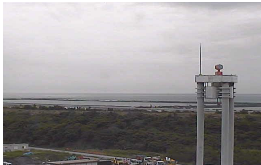
③ 平成28年4月 護岸築造工事
