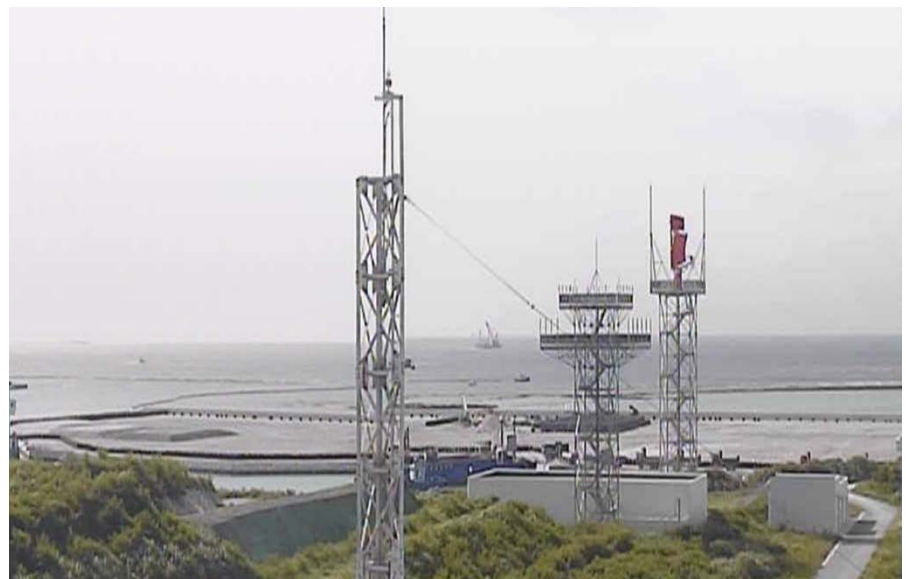
⑥ 平成28年6月 埋立工事
