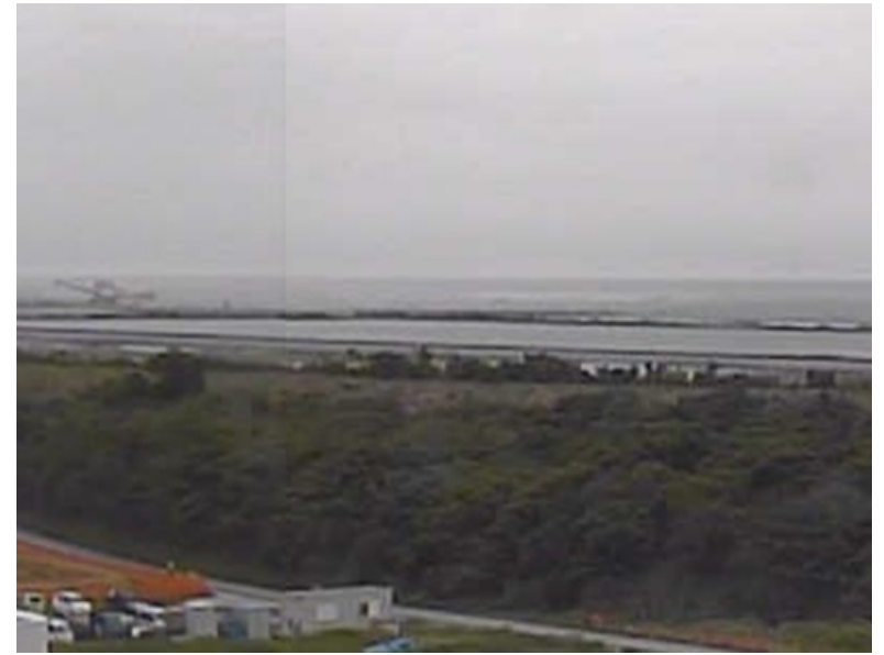
② 平成28年4月 護岸築造工事
