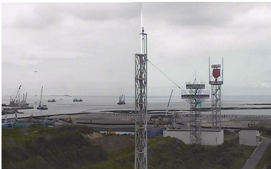
⑥ 平成28年5月 埋立工事
