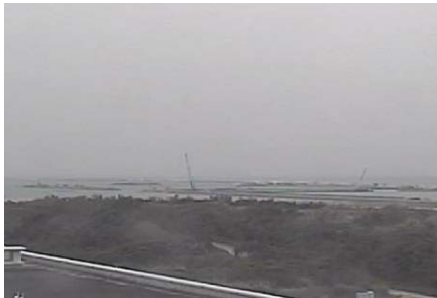
① 平成28年3月 護岸築造工事
