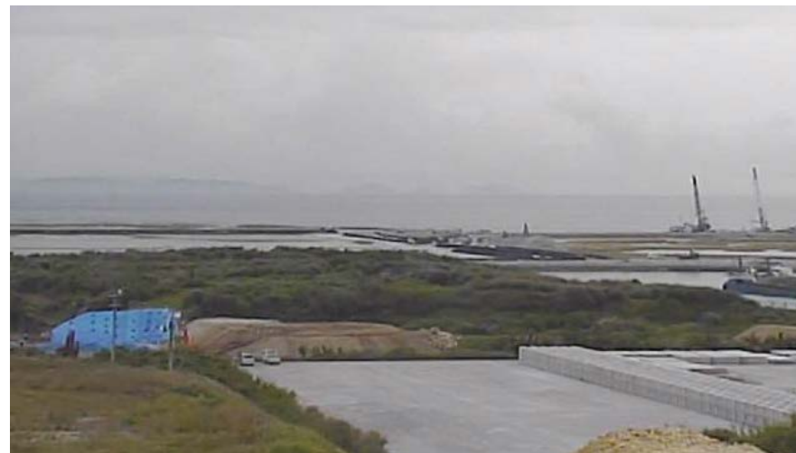
④ 平成28年4月 埋立工事
