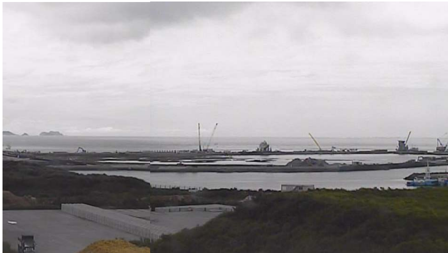
⑤ 平成28年5月 護岸築造工事
