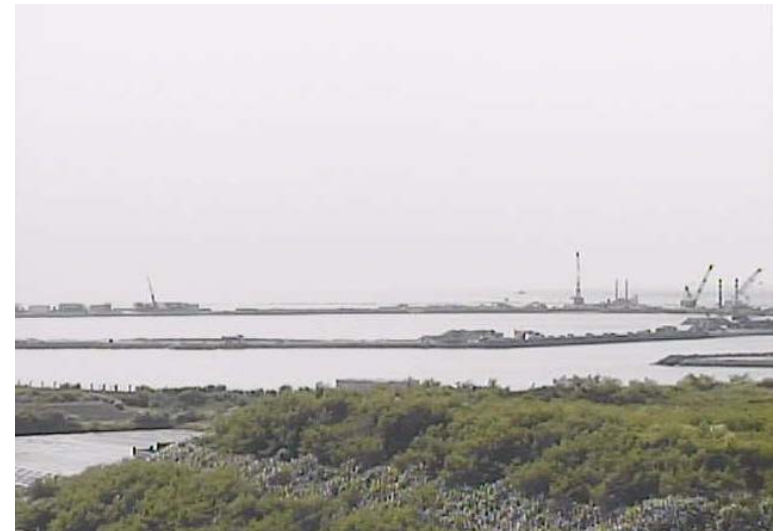
⑤ 平成28年6月 護岸築造工事
