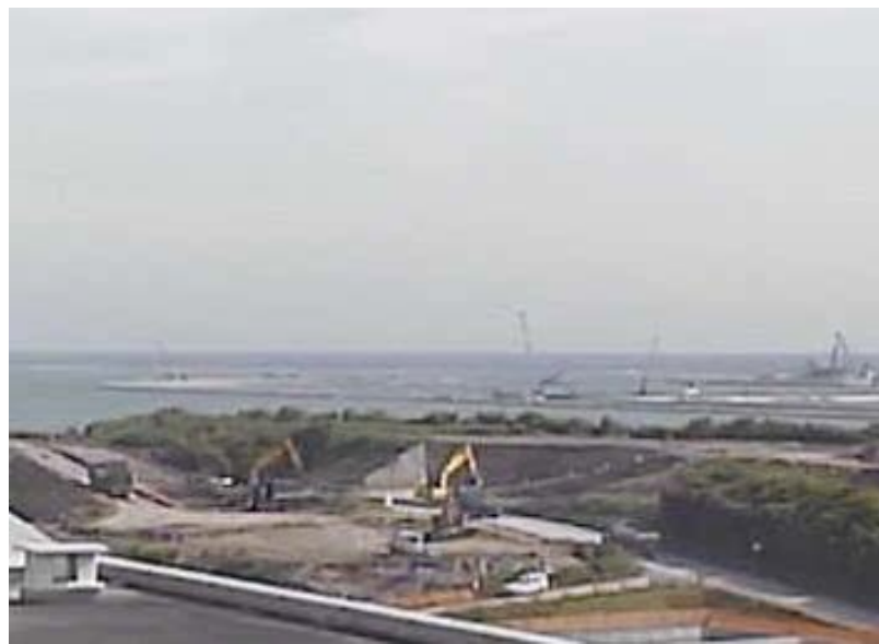
① 平成28年6月 護岸築造工事
