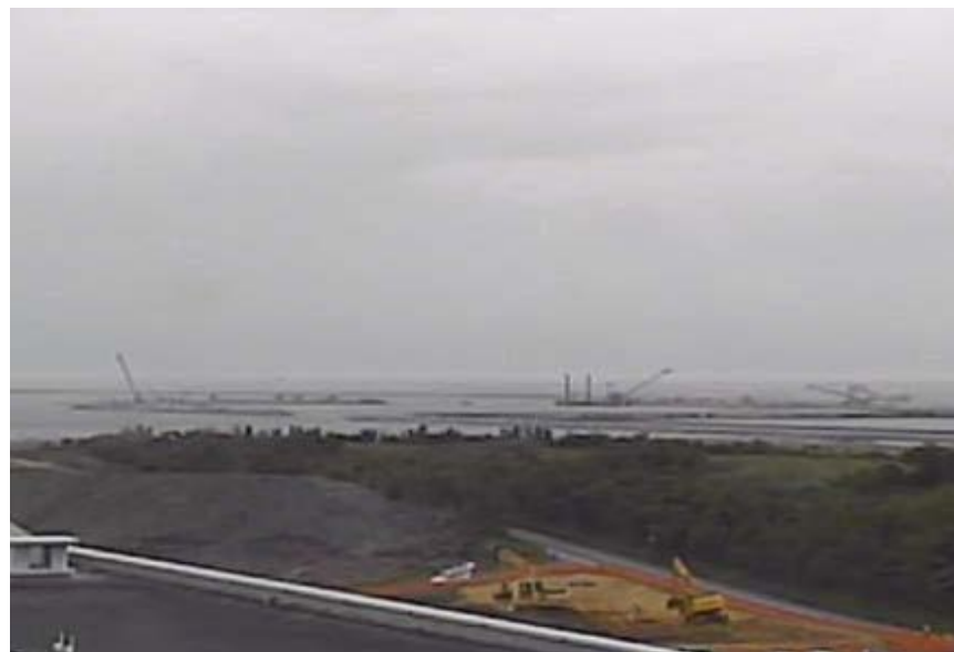
① 平成28年4月 護岸築造工事
