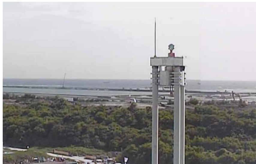
③ 平成28年6月 護岸築造工事
