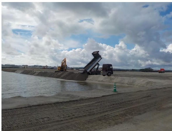
【Ⅲ工区】(平成28年7月撮影)
