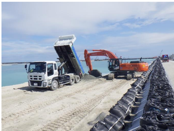
【Ⅲ工区】(平成28年6月撮影)
