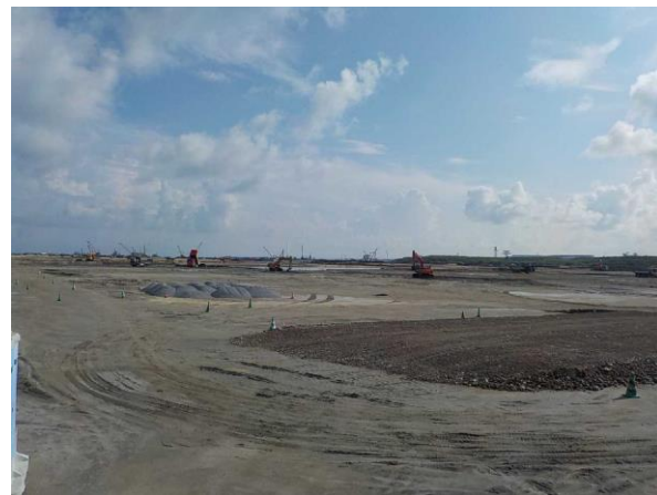
【Ⅲ工区】(平成28年7月撮影)
