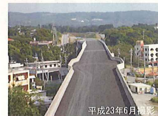
② 1号トンネル付近(起点側撮影)
