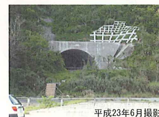
③ 2号トンネル世富慶付近
