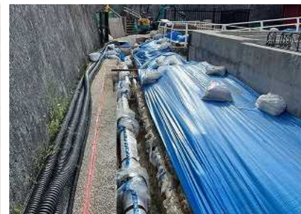
新たに拡充される防災設備 (連結送水管)
