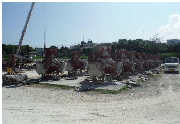
防波堤(下崎西)(改良)消波ブロック製作状況
