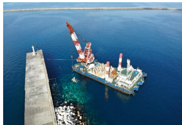
防波堤(下崎北)(改良)消波ブロック据付状況
