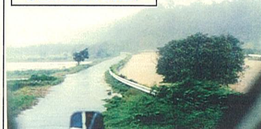
②金武大橋下流左岸
