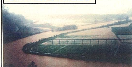
①金武大橋より下流を望む
