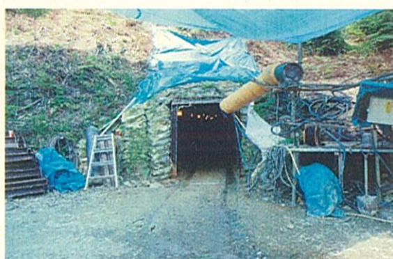
ダムサイトにおける地質調査(横坑)
