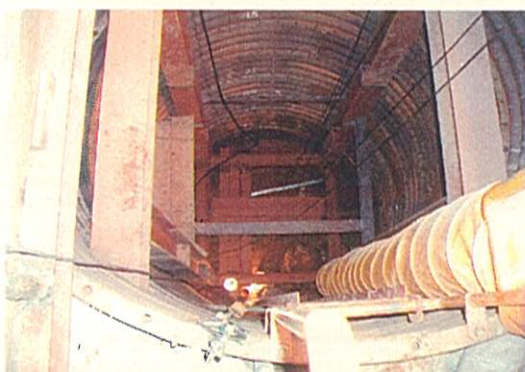
ダムサイトにおける地質調査(竖坑)
