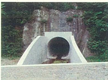
本ダム転流工(H13年度完成)
