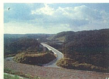
右岸工事用道路(H14年度完成)
