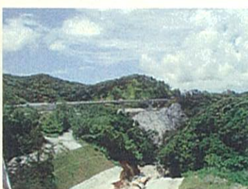
付替道路(H14年度完成)
