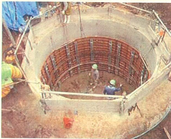
円筒型枠を用いた場所打ちモルタルで施工した例
