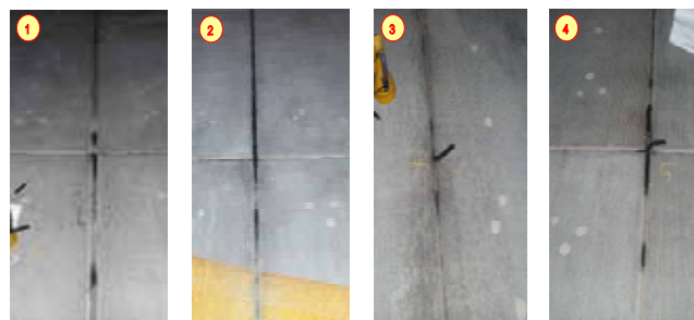
図 - 8 目地不具合箇所図(赤いライン中に発生)
