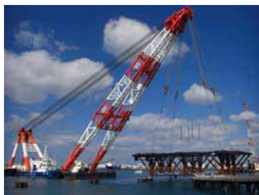
図-5 ジャケット据付状況(1,300t吊起重機船による)
