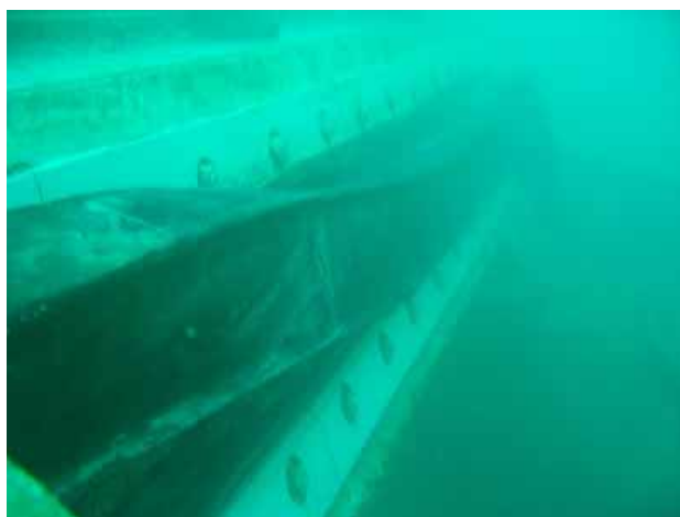
写真 - 7 伸縮性止水ゴムの押し出し状況
