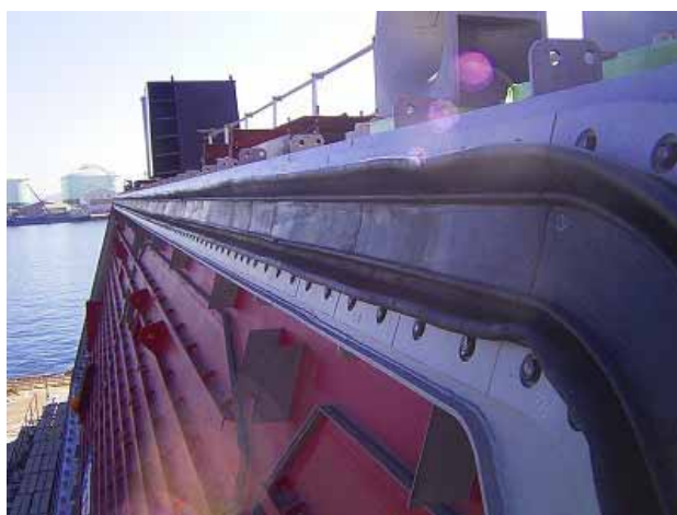
写真 - 1 伸縮性止水ゴム取付・収納状況
