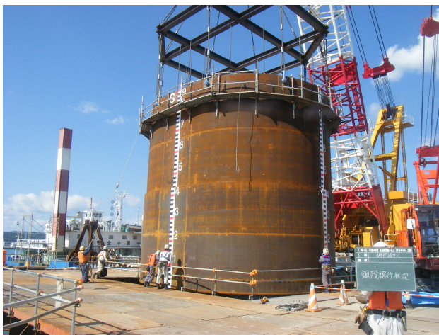
写真-1 鋼殻ケーソン据付状況
