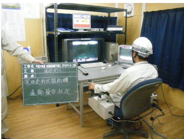
写真-4 無人機械掘削状況
