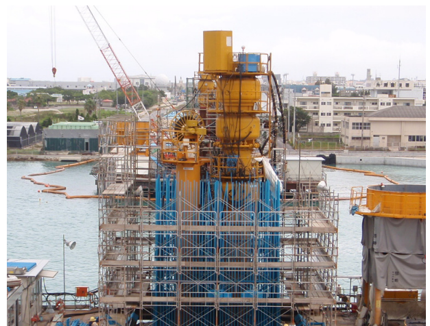
写真-2 ぎ装設備設置状況
