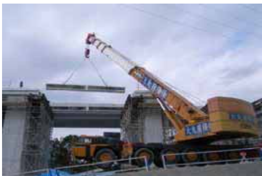
写真-5 主桁の撤去
