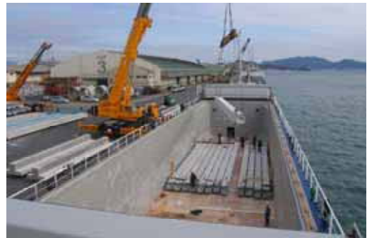
写真-2 主桁・横桁の海上輸送
