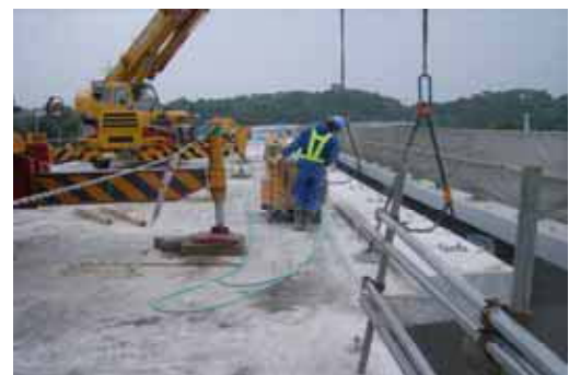
写真-4 張出床版の撤去
