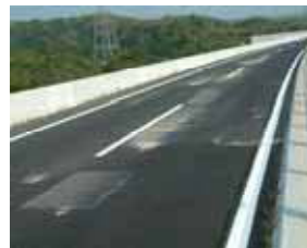
橋面舗装の補修状況
