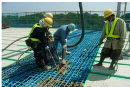
写真-8 連結部コンクリート打設
