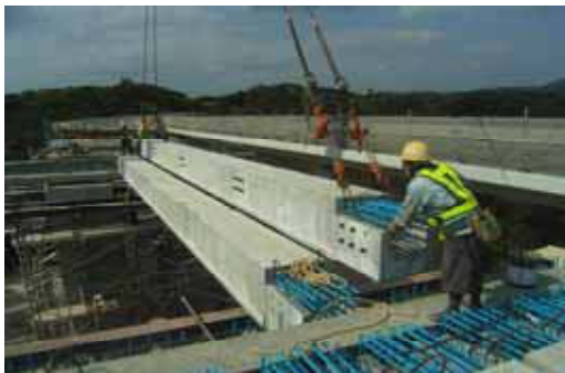
写真-7 主桁の架設
