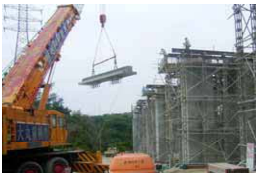
写真-6 横梁の架設
