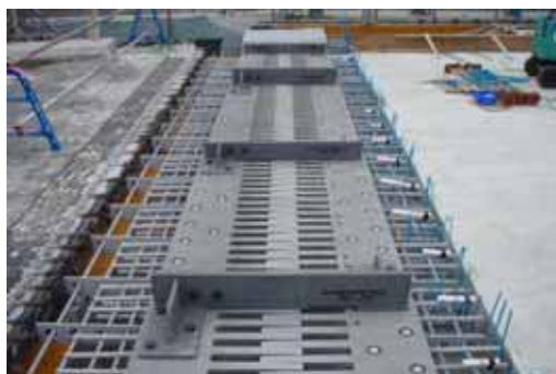
写真-9 伸縮装置設置
