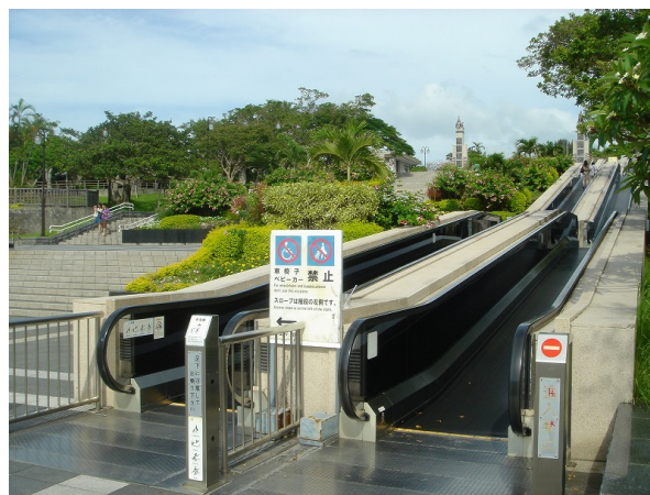
写真－12 動く歩道（噴水広場）
