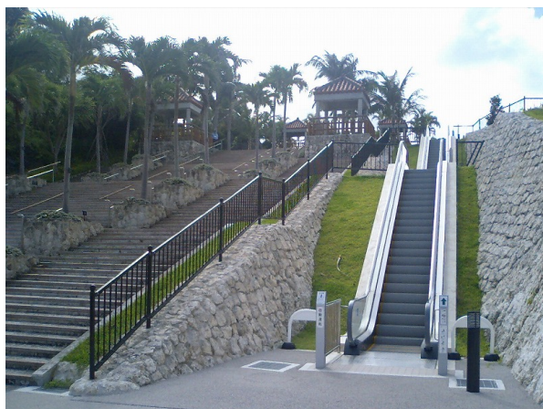
写真－11 黒潮階段のエスカレーター
