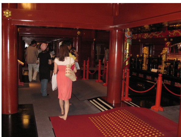
写真－１５ 正殿内部での段差解消対策
