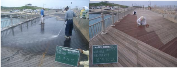
(板張清掃(左)・防虫、防腐塗料塗布写真-⑭)
