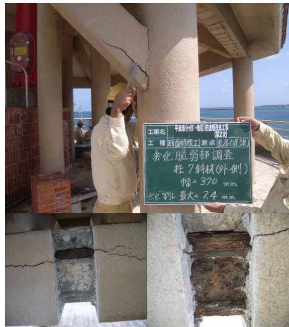
(鋼材腐食によるひび割れ確認写真⑪)
