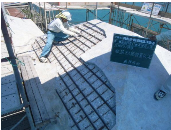
(補助鉄筋補強写真－④)
