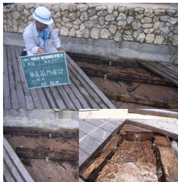
(根太材腐食箇所写真⑬)
