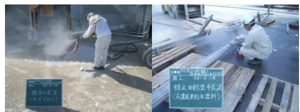
(鋼材錆除去(左)・防錆塗布(右) 写真⑫)
