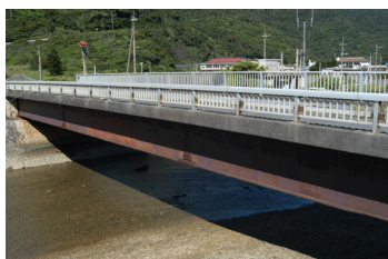
図-1 研究対象橋梁全景
