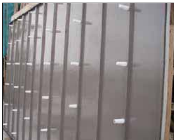
図-5 本換気塔で使用したゴム製型枠（壁部分）
