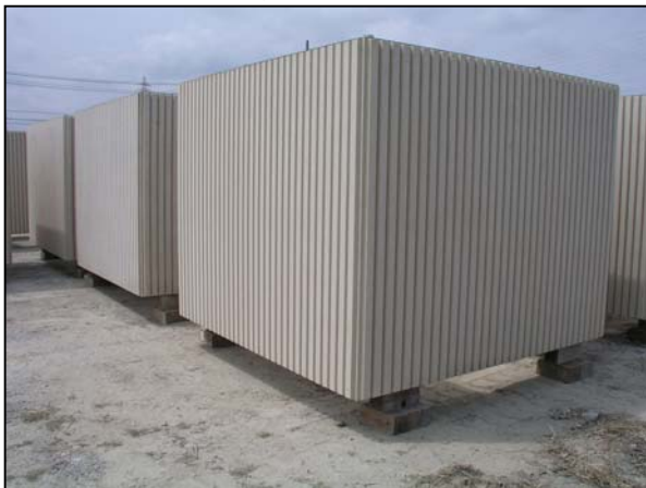
図-7 プレキャスト部材（ボックス）
