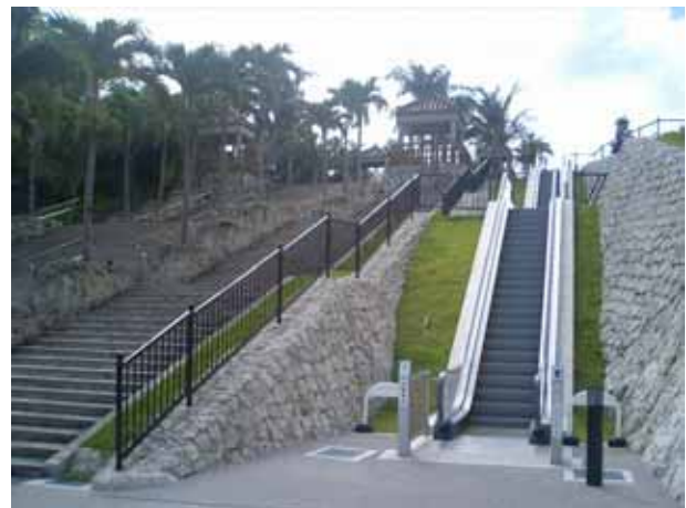
写真-16 黒潮階段のエスカレーター
