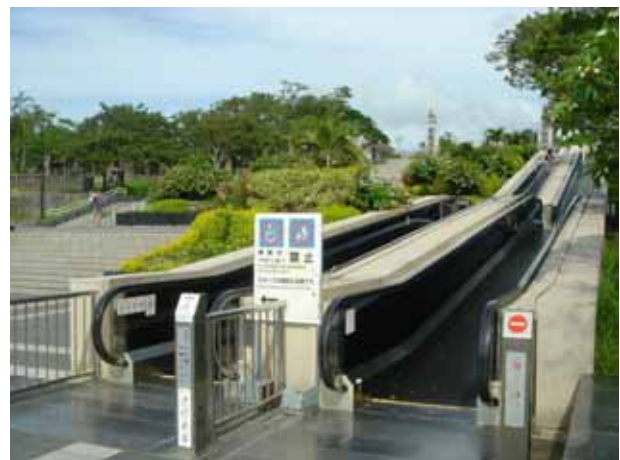
写真-17 動く歩道(噴水広場)
