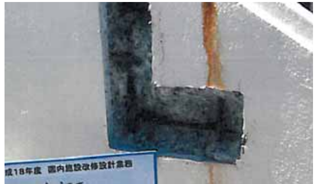
写真-6 壁はつり
