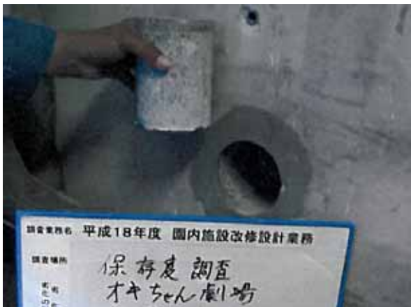
写真-4 コア抜き取り状況
