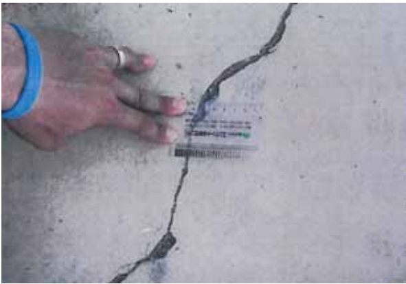
写真-3 ひび割れ測定
