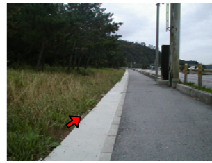
(a) 張りコンクリート施工例
