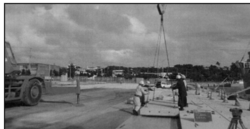
図-17 プレキャストRC版設置状況
