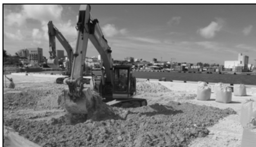
図-15 施工状況（表層改良工法）
