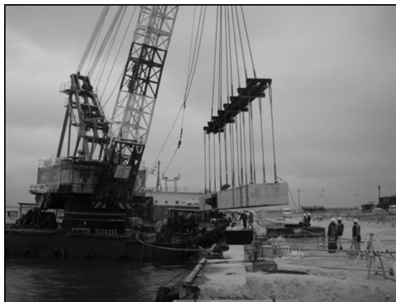
図-8 プレキャスト上部工据付状況
