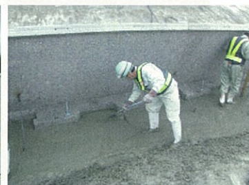
写真-16 PC型枠底盤モルタル充填状況
