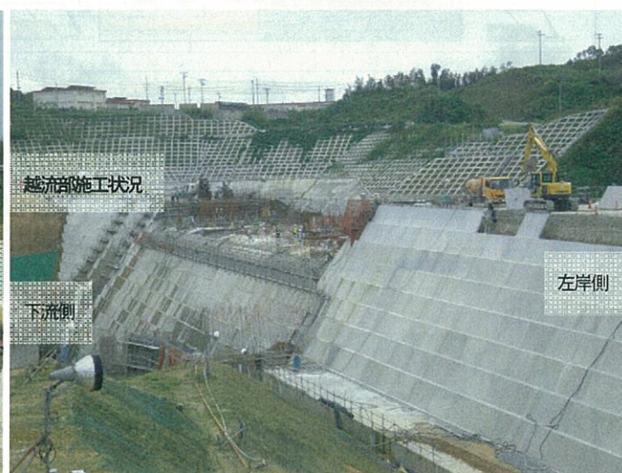
写真-18 左岸下流より上流を望む
