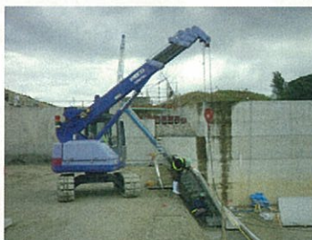
写真-15 PC型枠設置状況
