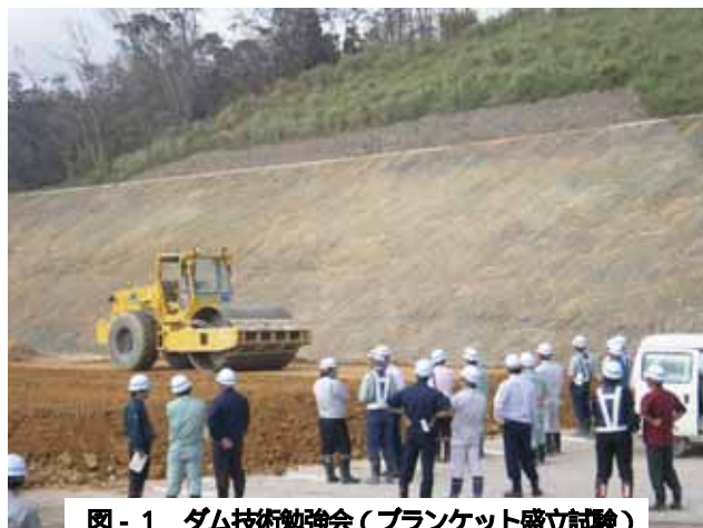
図 - 1 ダム技術勉強会（プランケット盛立試験）
