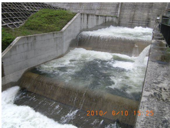
図-3 10m 3 /s を放流している状況
