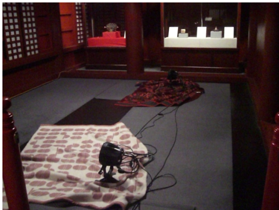
写真-9 正殿内部の床面の保護
