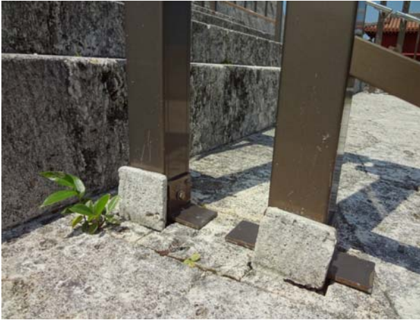
脱着式手すり（石蓋で隠れる構造）
