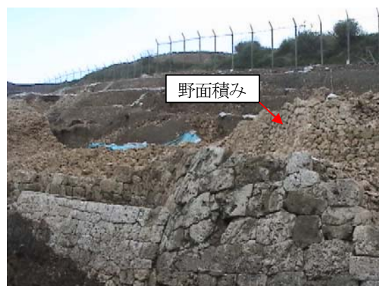
首里城外郭石積（久慶門付近）
