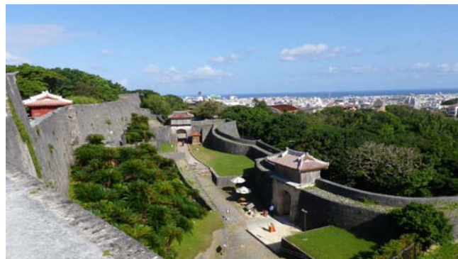
久慶門から奥の歓会門を結ぶ石積み曲線
