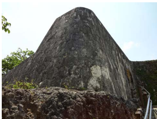
琉球石灰岩の岩盤に積まれた石積み（首里城の京の内）
