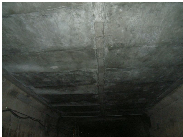
写真－１０ 頂版部補修完了状況
