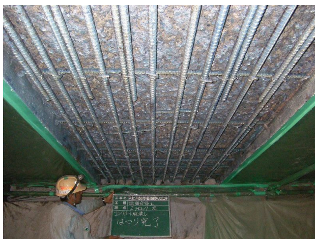
写真-6 1.5mハツリ完了状況
