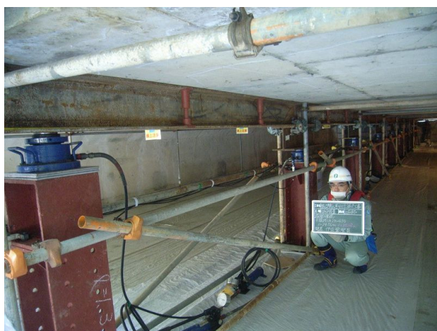
写真-5 頂版部押さえ材・中間支持部材配置状況
