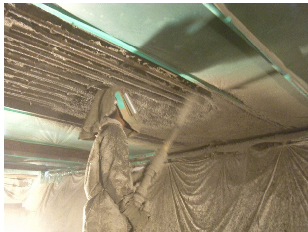
写真－９ ポリマーセメントモルタル吹き付け状況
