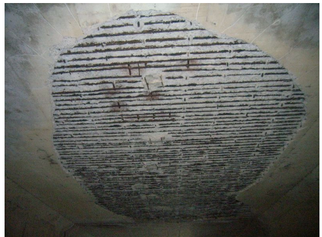
写真-2 頂版部コンクリート剥落状況
