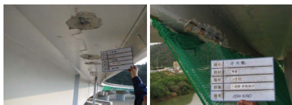
写真-3 A1ーP5径間の損傷状況
