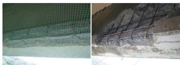
写真-4 P5ーA2径間の損傷状況
