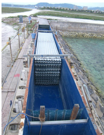
〔写真-10〕傾斜板設置状況
