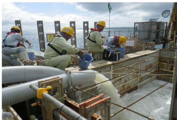
〔写真-6〕凝集剤対策状況
