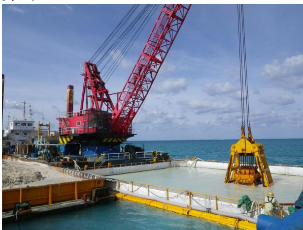
〔写真-1〕浚渫作業状況
