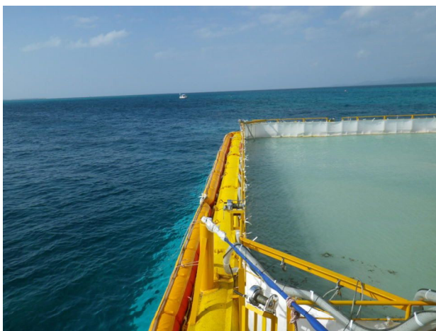
〔写真-2〕枠内、外の濁水状況
