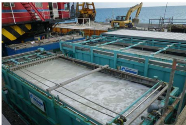
〔写真-4〕強制濾過対策状況
