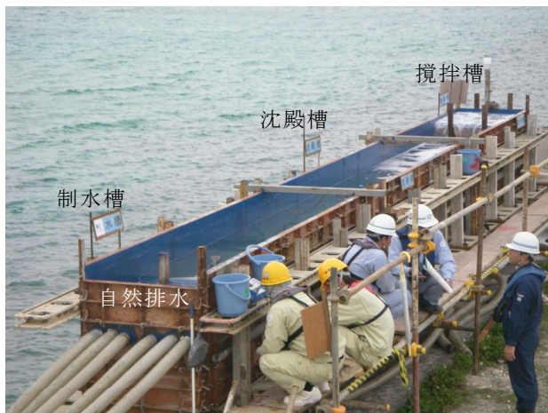
〔写真-9〕「循環方式」による試験状況
