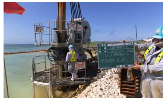
矢板打設状況（クリア工法）
