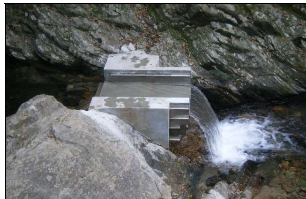
写真-3 保全対策 (本川部) コンクリート水路設置 H2303施工
