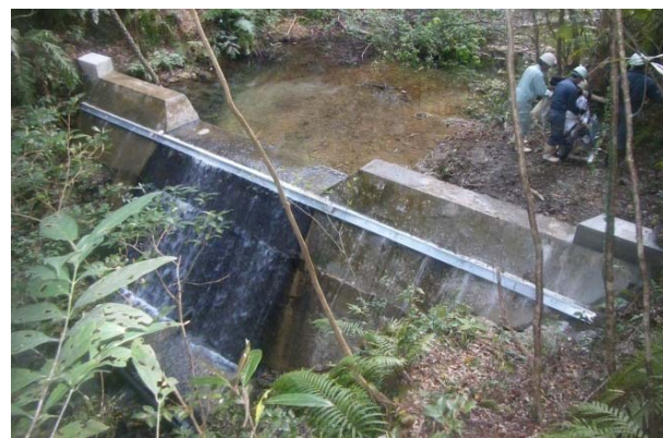
写真-4 保全対策 (支川部) C型鋼設置 H2303施工
