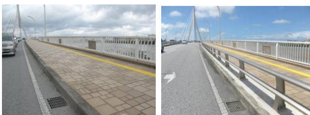
写真-2 防護柵施工事例(左：施工前 右：施工後)
