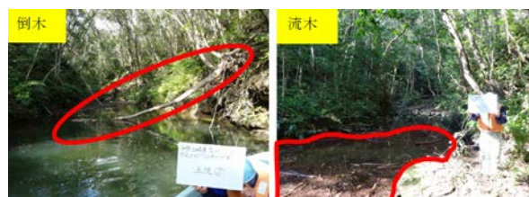
写-3 上流部の倒木・流木状況
