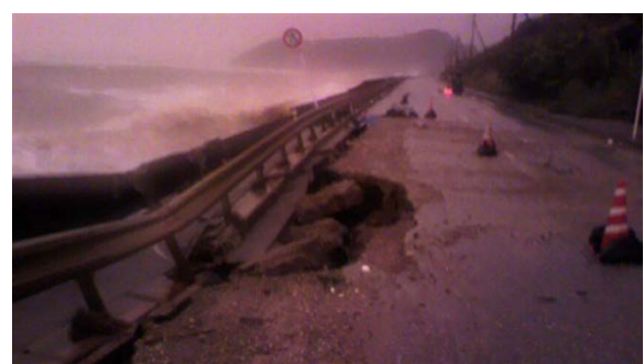
写真-4 被災状況 （大宜味村喜如嘉：護岸洗掘による陥没）
