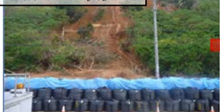
写真-1 被災状況（大宜味村根路銘） （台風15号で崩れたため応急処置としてトン土のうを設置したが、台風16号で再度押し流された）
