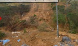
写真-1 被災状況（大宜味村根路銘） （台風15号で崩れたため応急処置としてトン土のうを設置したが、台風16号で再度押し流された）
