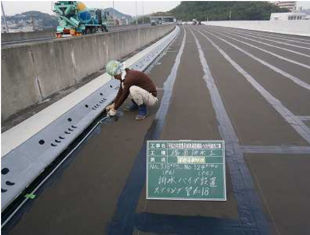
写真-3 津嘉山高架橋上：橋面防水工施工
