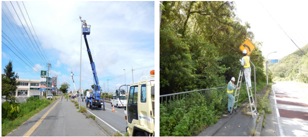
写真－１ 点検（左：照明点検 右：標識点検）
